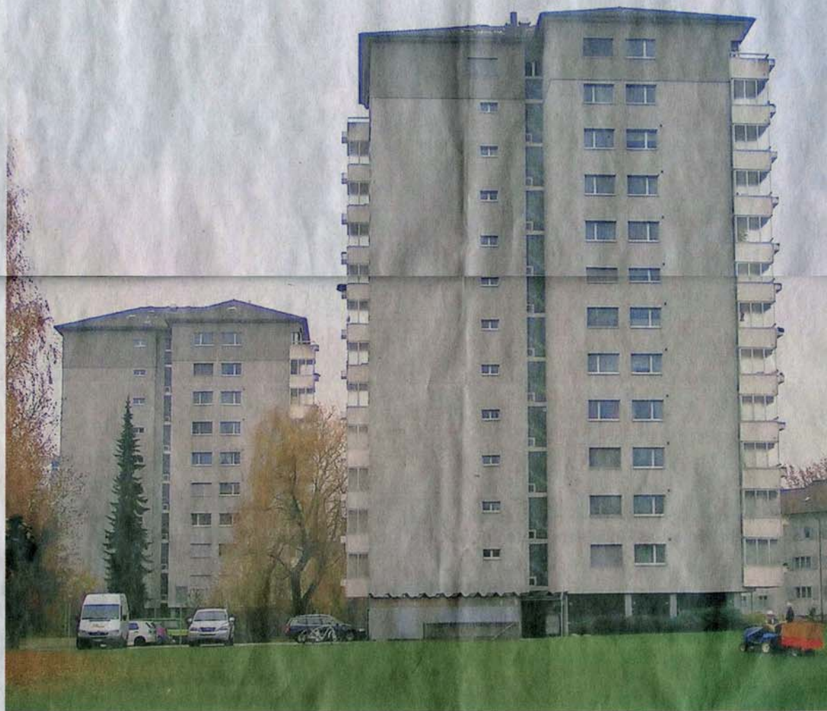
Vor 20 Jahren wurden die beiden Hochhäuser aussen saniert; nun folgt die Innensanierung.
